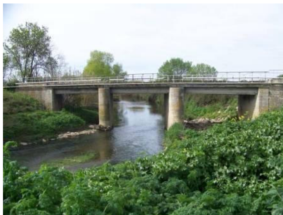
Pont du chemin de fer de Nîmes à Aigues Mortes sur le Vistre.
